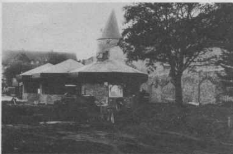
Unser Bild zeigt die Stelle, an der das Fundament freigelegt wurde. Nach der Vermessung schüttete man es wieder mit Sand zu, um öffentliches Aufsehen zu vermeiden.
